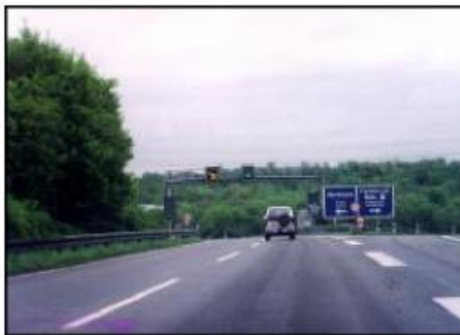
تصویر ۸۶- چراغ‌های کنترل باند
