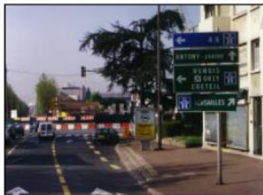
تصویر ۶۸- تغییر مسیر به سمت منطقه عملیات اجرایی، فرانسه
