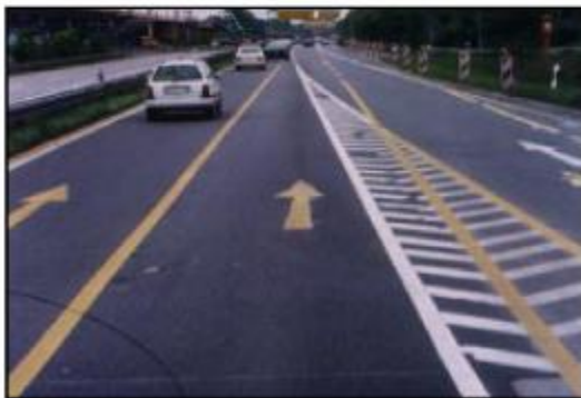
تصویر ۲۳- خط‌کشی‌های زردرنگ در منطقه کارگاهی، آلمان
