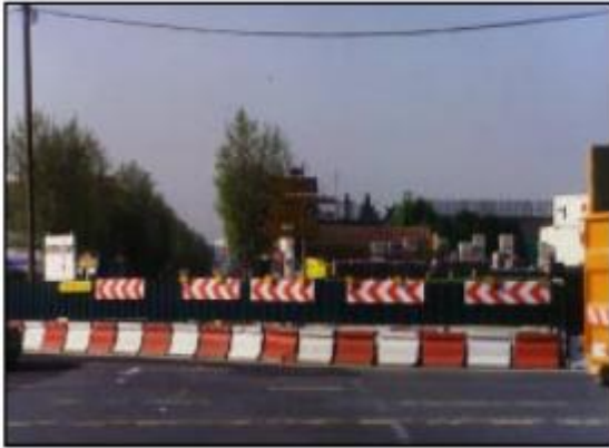
تصویر ۶۹- حفاظدهای منطقه عملیات اجرایی، فرانسه
