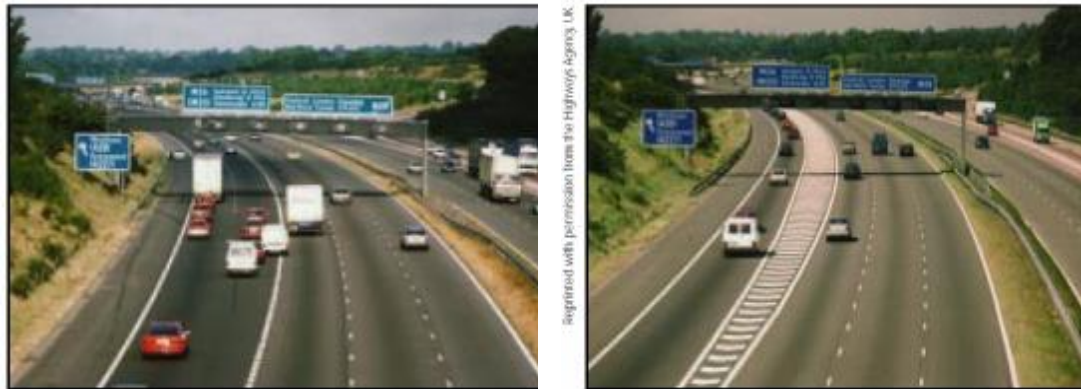
تصویر ۲- وضعیت قبل و بعد از بکار بردن خط کشی جهت دار روی رمپ خروجی
