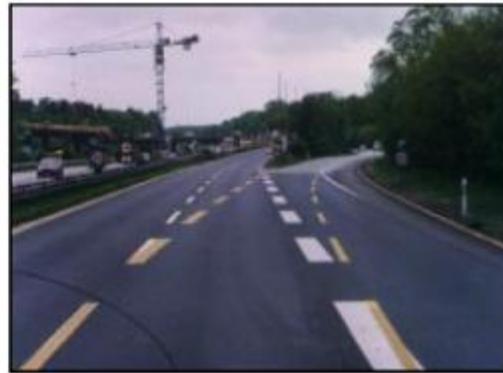
تصویر ۲۲- خط‌کشی‌های زردرنگ در منطقه کارگاهی، آلمان
