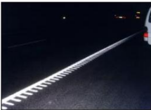
تصویر ۳- خط کناری در تونل Lundby در سوئد
