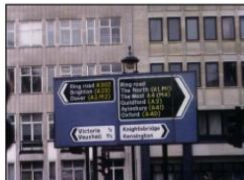
تصویر ۳۰- تابلوهای پیکان‌شکل نصب‌شده روی یک تخته
