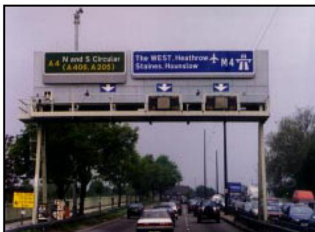
تصویر ۴۲- تابلوی مسیر خروجی آزادراه، انگلستان (به چراغ‌های کنترل باند روی دو باند راست توجه کنید)
