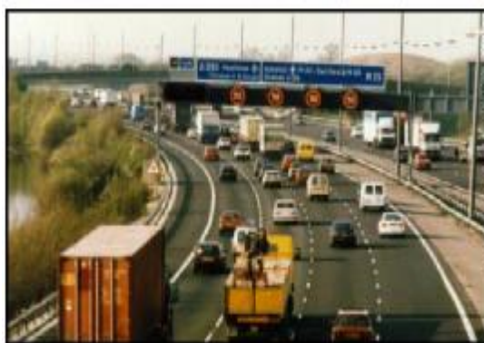
تصویر ۸۲- کنترل متغیر سرعت
