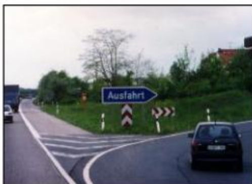
تصویر ۲۷- تابلوی پیکان‌شکل در رمپ خروجی، آلمان
