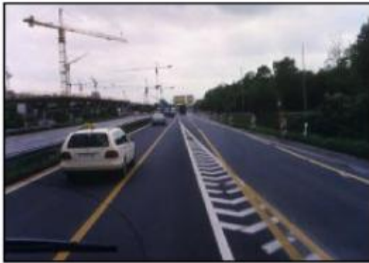
تصویر ۲۱- خط‌کشی‌های زردرنگ در منطقه کارگاهی، آلمان
