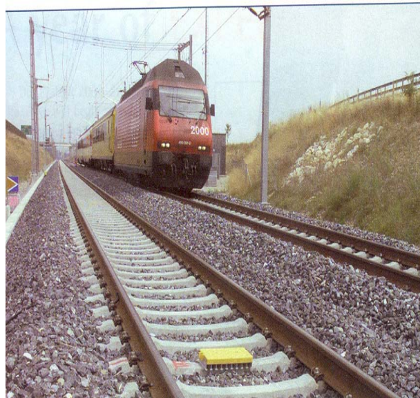
شکل ۷-۳-۴- سیستم نصب شده در وسط خط [۵۵]
